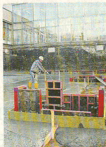
Thomas Krien arbeitet am Boden der künftigen Tiefgarage.
