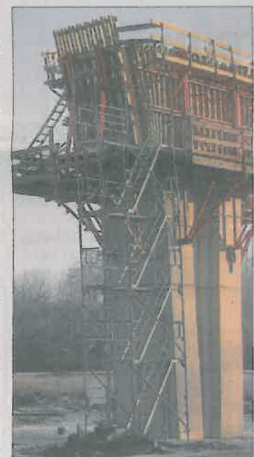
Das Vorschubgerüst an den Pfeilern, die auf gewaltigen Fundamenten stehen. Fotos: is
