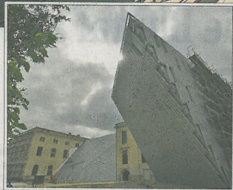
Mit Alu-Paneelen verkleidet durchbricht der moderne Keil das alte Arsenalgebäude.
