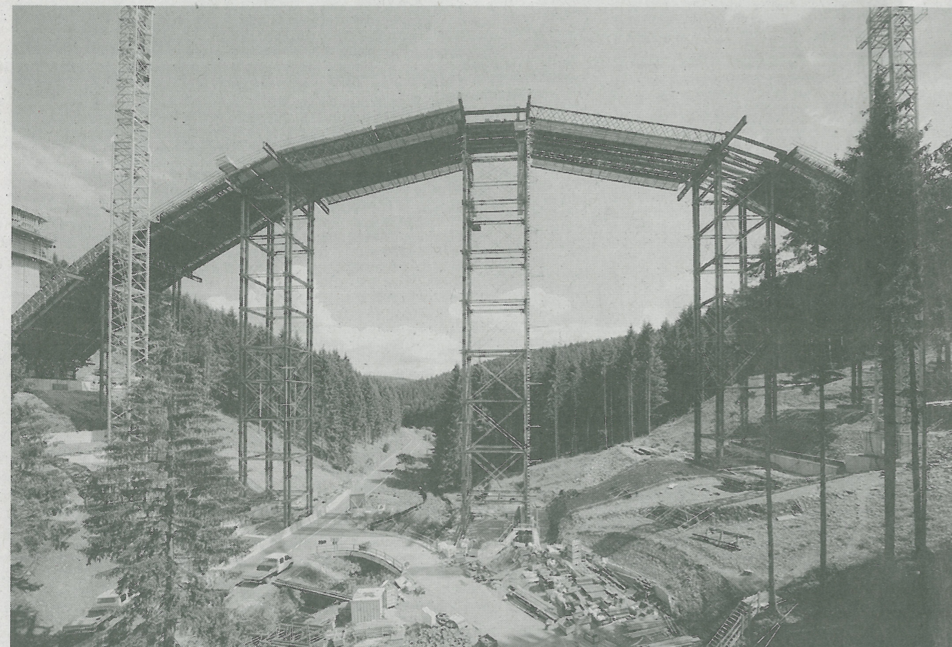
Im Zuge des Baus der Eisenbahn-Neubaustrecke Ebensfeld–Erfurt entsteht derzeit die 385 m lange Massetalbrücke. Ihr Stahlbetonbogen (Stützweite: 165 m) hat einen Hohlkastenquerschnitt, der mit Hilfe eines bodengestützten Traggerüsts von beiden Kämpfern aus abschnittsweise in symmetrischen Takten – Bodenplatte vorausseilend – geschalt und betoniert wird. Fotos: RöRo Traggerüstsysteme
