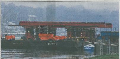
Die beiden 60 Meter langen Pontons sind bereit. Allerdings müssen die roten Gerüste darauf noch auf die genaue Höhe eingestellt werden, damit das Vorderteil des Bogens sicher darauf liegt.
