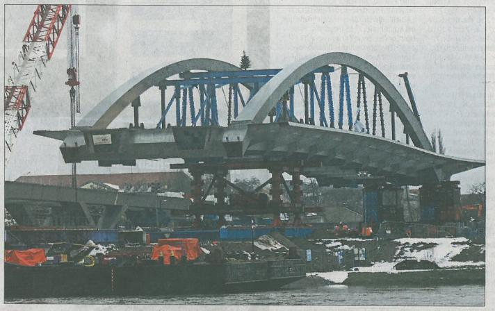
Verschubfertig steht der Brückenbogen am Johannstädter Elbufer. Vorgesehen ist. dass die 1800 Tonnen schwere Stahlkonstruktion ab morgen das letzte Stück bis zum Ufer geschoben wird. Am Wochenende könnte sie dann auf den Pontons übersetzen. Die Aktion sollte bereits am 7. Dezember beginnen. Doch aufgrund des stark schwankenden Wasserstands musste sie verschoben werden.
