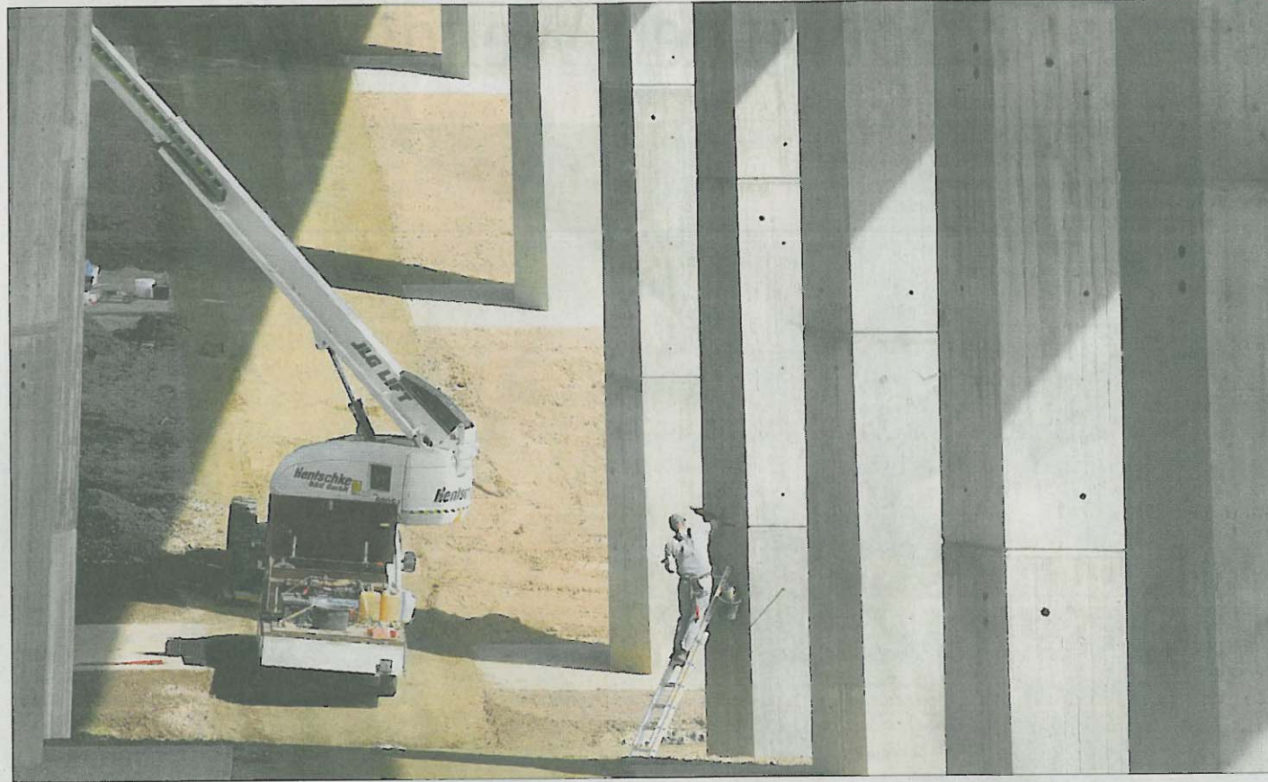
Auf 20 Betonfeilern steht die Brücke der neuen B 178 bei Carlsbrunn unweit von Löbau. Bis auf Restarbeiten ist das 290 Meter lange und bis zu 18 Meter hohe Bauwerk fer-
