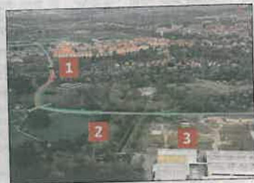
Blick aus Richtung Humboldtthain
