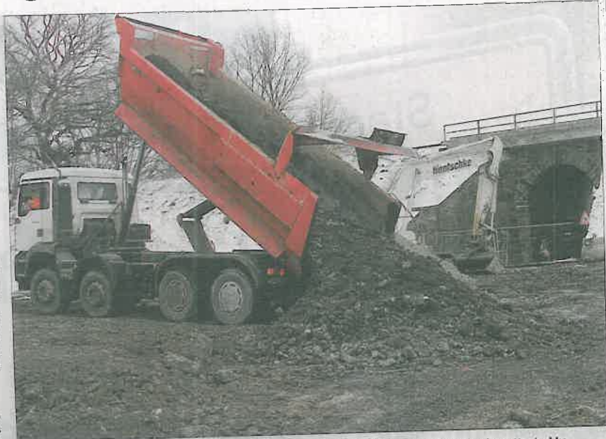
Ein Lastwagen lädt an der Daimlerstraße Erde ab. Hier wird das Baufeld vorbereitet: Die Firma Hentschke braucht Platz, um ab März die Bahnbrücke (hinten) durch einen Neubau zu ersetzen. Foto: SZ/Uwe Soeder, Straßenbauamt Bautzen
