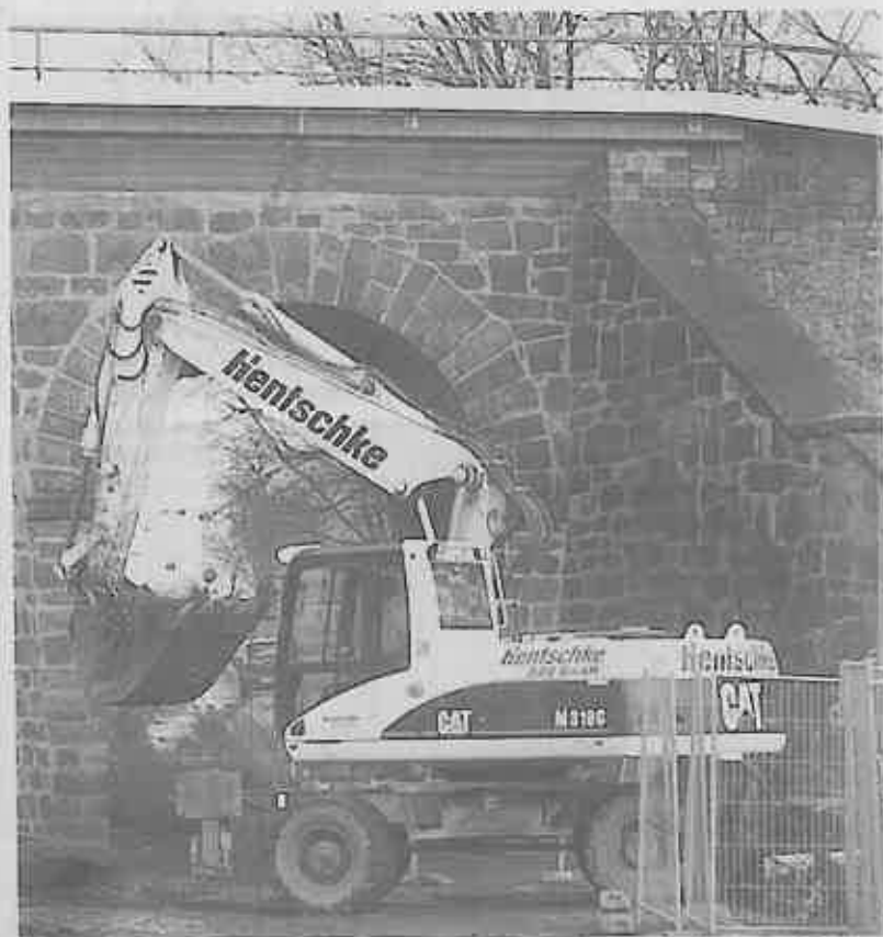
An der Bahnbrücke über die Bautzener Daimlerstraße hat am Montag die Baufeldfreimachung begonnen.
