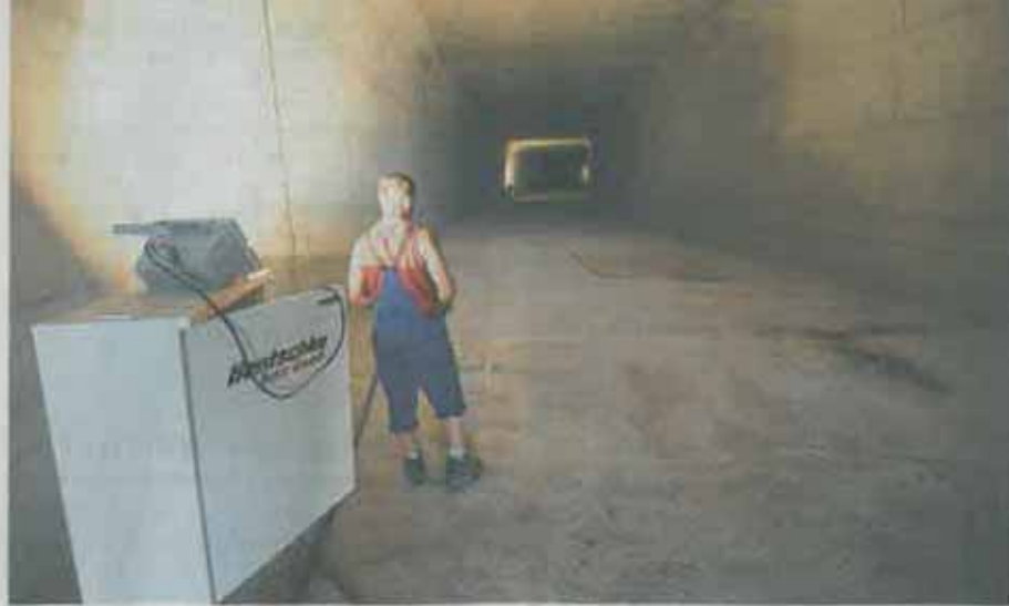
Der etwa 300 Meter lange östliche Ausfahrtunnel der Waldschlößchenbrücke auf der Neustädter Elbseite ist bereits so gut wie fertig.
