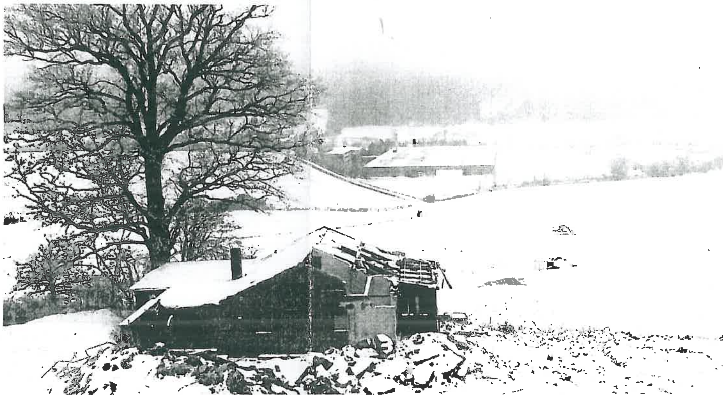
Zwischen den Gebäuden des Pora-Firmenkomplexes (im Hintergrund) wird in rund 40 Metern Höhe die Füllbachtalbrücke vom Rennberg aus Richtung Süden führen. Für die „Berliner Hütte“ wird der Brückenbau das endgültige Ende bedeuten.
