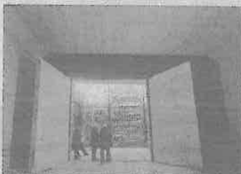
Solche Türen sichern derzeit die Tunnelportale. So bleibt es innen wärmer. Außerdem kommen unbetonte Gäste nicht in die Röhren.
