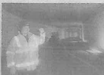
Baubereiter Hans-Joachim Kummert inspiziert den östlichen Ausfahrtstunnel. Die Wände sind schon gestrichen, die Straße asphaltiert.
