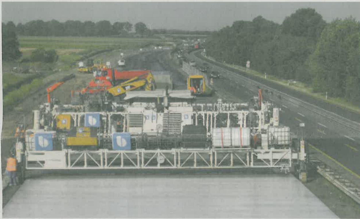
Betonfertiger im Einsatz.
