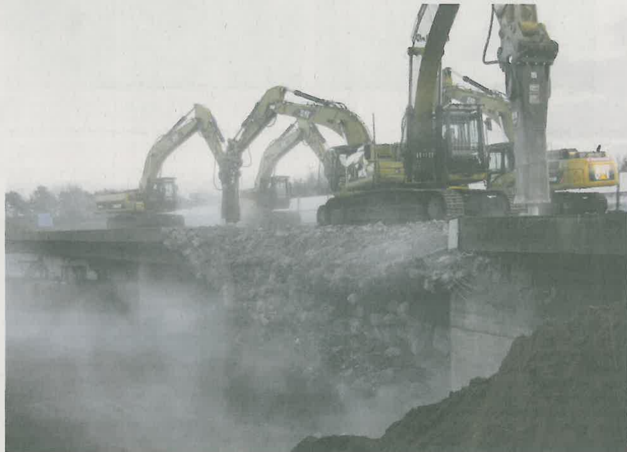
Maschineneinsatz beim Abbruch von Brückenbauwerken.
