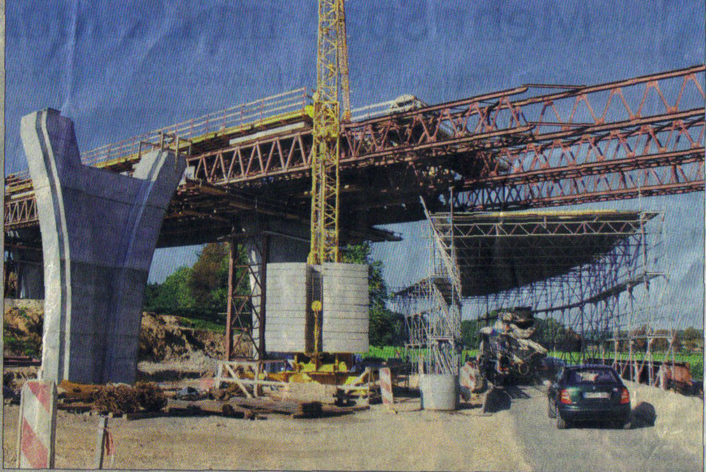
Autobahnbrücke bei Dämelow: Einige Meter über dem Gerüst, das die Autofahrer schützt, arbeiten die Brückenbauer am zweiten Segment.
