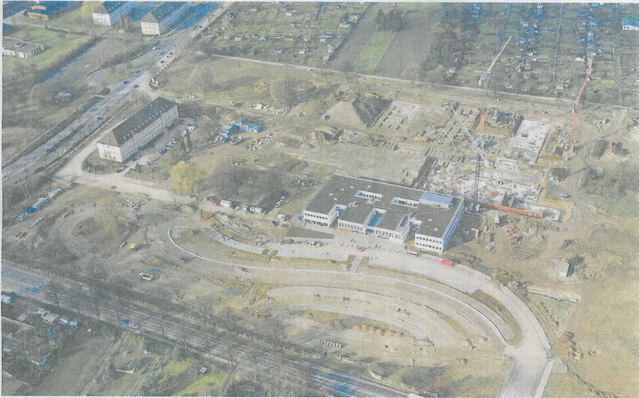
Zwischen Goslarscher Landstraße (vorn) und Pflugstieg (oben) wächst das neue Rhön-Klinikum empor. Das Ärztezentrum (Mitte) ist fast fertig, das Haus Nummer sechs aus Bundeswehr-Zeiten (links) bleibt erhalten. Foto: Hartmann
