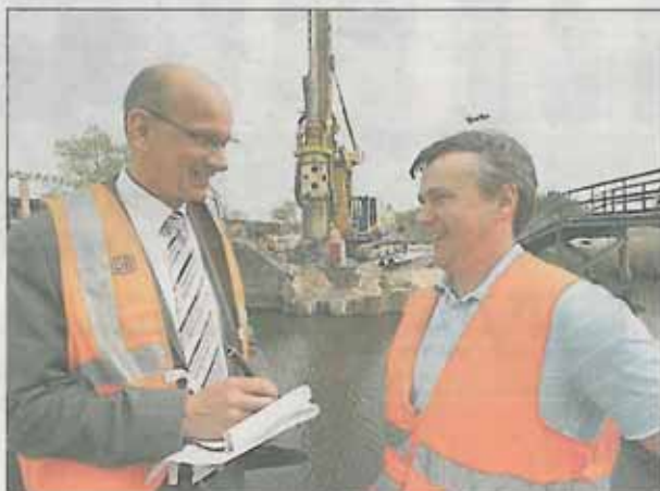
Bernd Homfeldt (links) und Bauleiter Jens Kadler bei der Lagebesprechung am Ufer der Schwartau. Dort entsteht auch eine neue Eisenbahnbrücke. Im Hintergrund (rechts) ist eine alte Fußgängerbrücke zu sehen.
