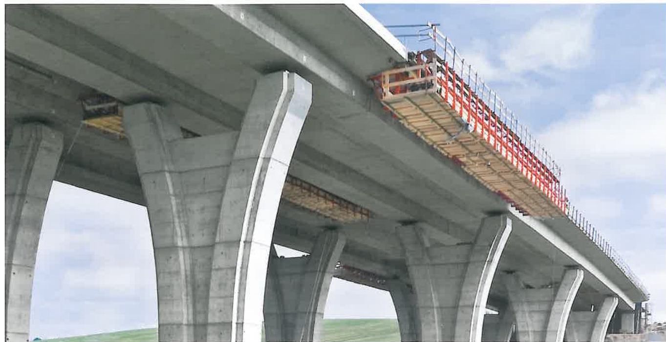
Drei VARIOKIT Gesimskappenbahnen an der 340 m langen Talbrücke Liessow.
