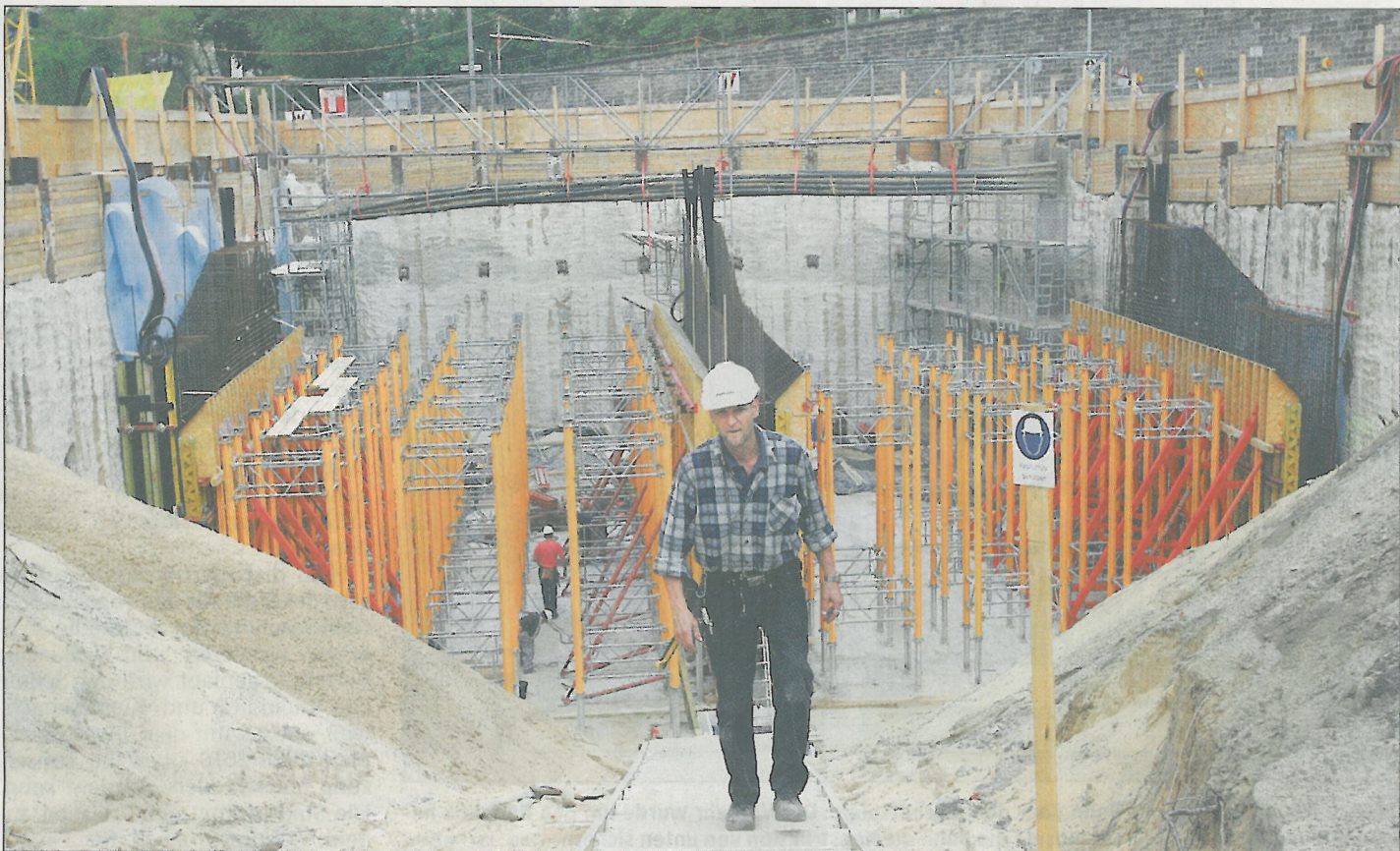
Vorarbeiter Henry Wittke auf dem Weg nach oben. Die Bodenplatte des ersten Abschnitts des künftig vierspurigen Zufahrtstunnels am Waldschlößchen ist fertig. Jetzt wird der Bau der Tunneldecke vorbereitet.
