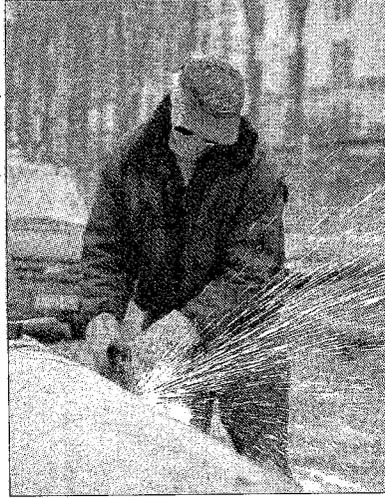
Mit dem Schneidbrenner zerteilt Gunter Welz eine alte Wasserleitung auf der Stauffenbergallee.
