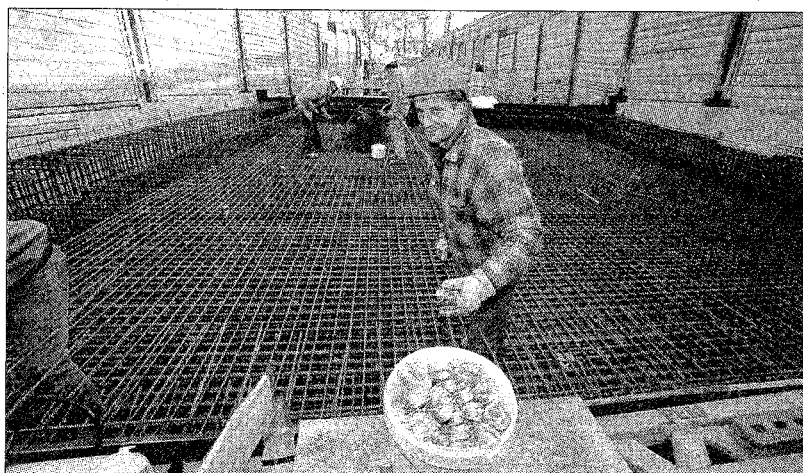
Mladen Simoic (vorn) und seine Kollegen flechten derzeit die Stahlbewehrung für den ersten Abschnitt der Tunnelplatte an der künftigen Ostausfahrt. Der Tunnel an der Bautzner Straße wird 300 Meter lang.
