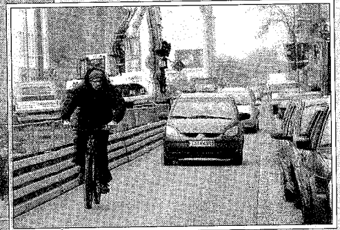
Während des Baus war die Strecke halbseitig gesperrt. Da wurde es für Radfahrer oft eng. Fotos: Steffen Füssel (4)
