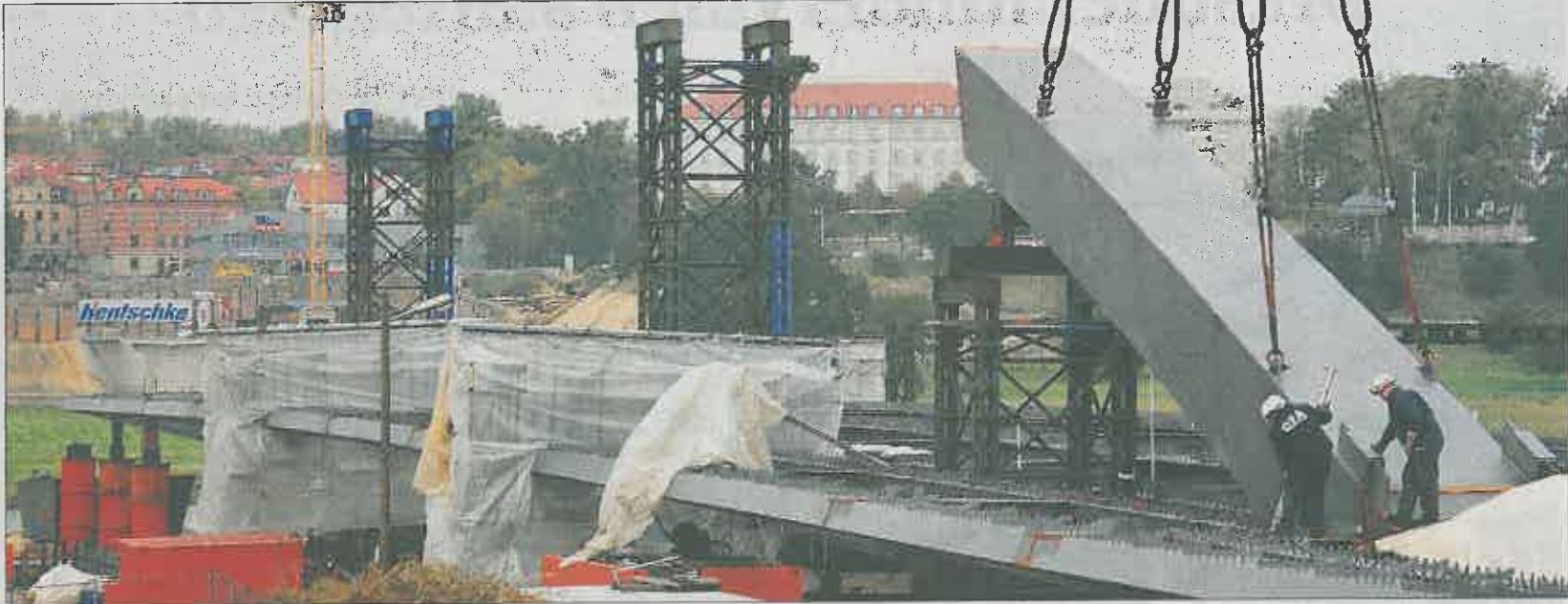
Gestern wurde das erste von zehn Bogenteilen für die Waldschlößchenbrücke eingehoben. Bis Dezember soll das 148 Meter lange Mittelstück montiert sein, das künftig die Elbe überspannen wird. Es wird mit Spezialtransportwagen und auf Pontons über den Fluss rollen und schwimmen. Foto: Marco Klingner
