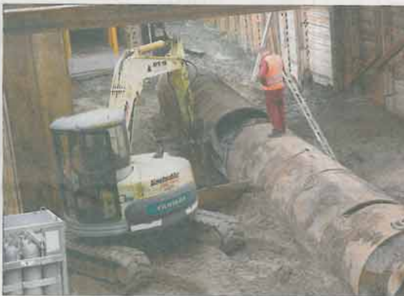
Das Rohr wird mit einem Meißel zerteilt und getrennt herausgezogen.
