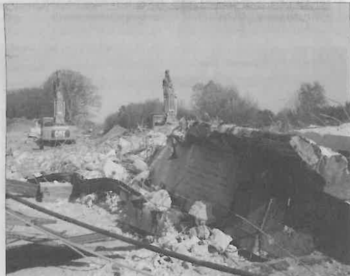
Zertrümmert werden die Brückenbauteile vor Ort. Danach können sie der Entsorgung zugeführt werden.
