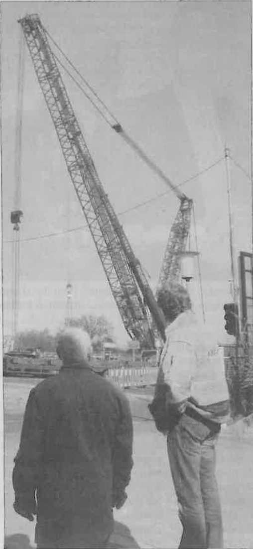
175 Tonnen Stahl und Beton wurden aus dem Brückenverbund herausgelöst und schweben nun über Behelfsbrücke (rechts) und Bahnleise hinweg zum vorbereiteten Platz, wo die Brückenteile zur Entsorgung zerkleinert werden. Fotos: dig (3), sch/t (1)
