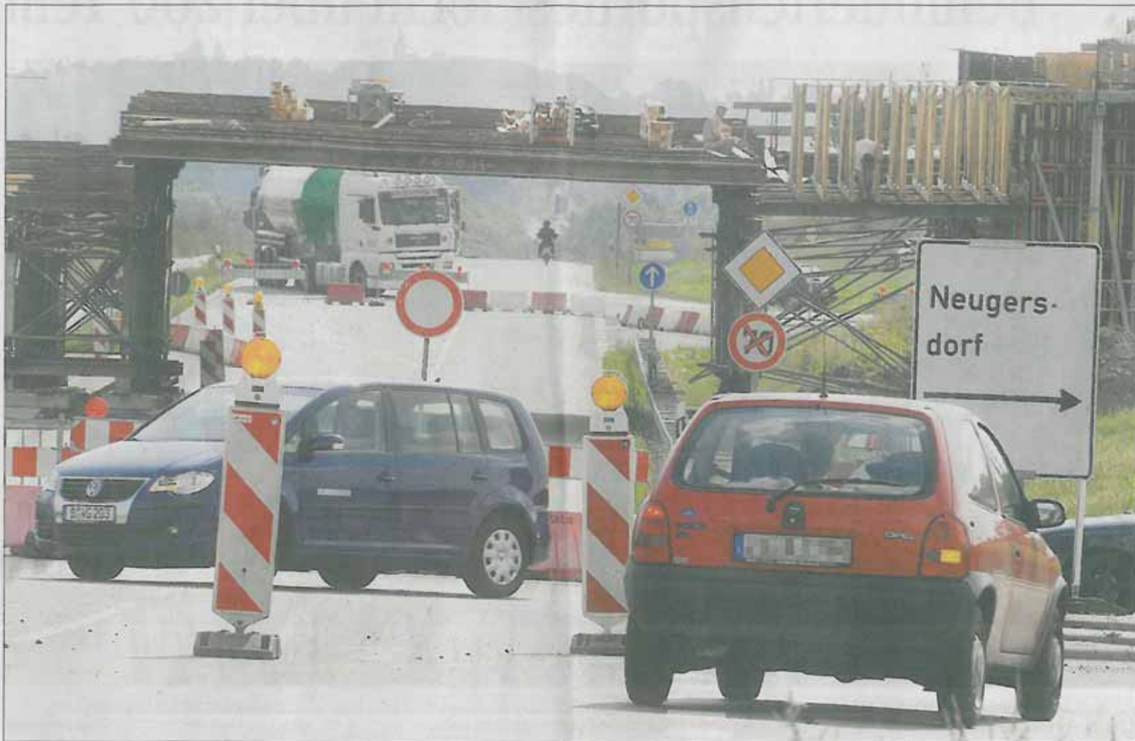
In einer Art Kreisverkehr fließt der Verkehr an der Brückenbaustelle vorbei.
