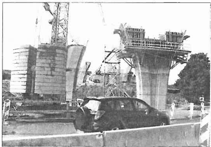
Die ersten Stützen stehen. Direkt an der Baustelle ist es eng. Deshalb können die Autos auf der Landesstraße, die die Autobahntrasse quert, jeweils nur in eine Richtung rollen. Ampeln regeln den Verkehr.
