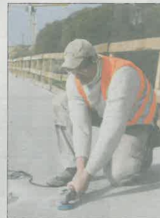
Sylivo Fischer glättet den Beton. Fotos: Werner Mett (2)
