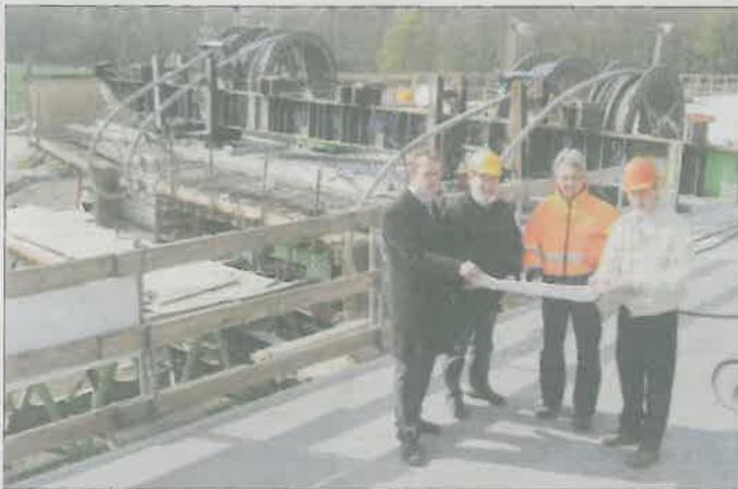
Arbeitstreffen in luftiger Höhe: Verkehrsminister Volker Schlotmann (2.v.l.) lässt sich die Konstruktion der Liessower Talbrücke erläutern.
