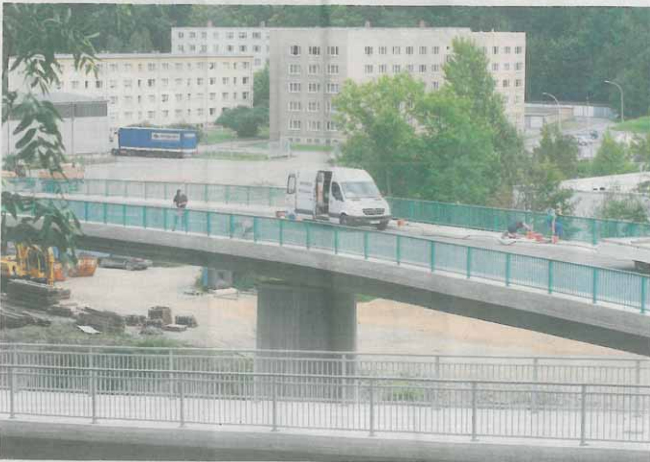
Letzte Arbeiten am Geländer wurden in den vergangenen Tagen noch an der Elsterberger Brücke vorgenommen. Heute, 10 Uhr, wird die neue Brücke über die Weiße Elster und die Eisenbahnstrecke Weischlitz – Gera freigegeben.
