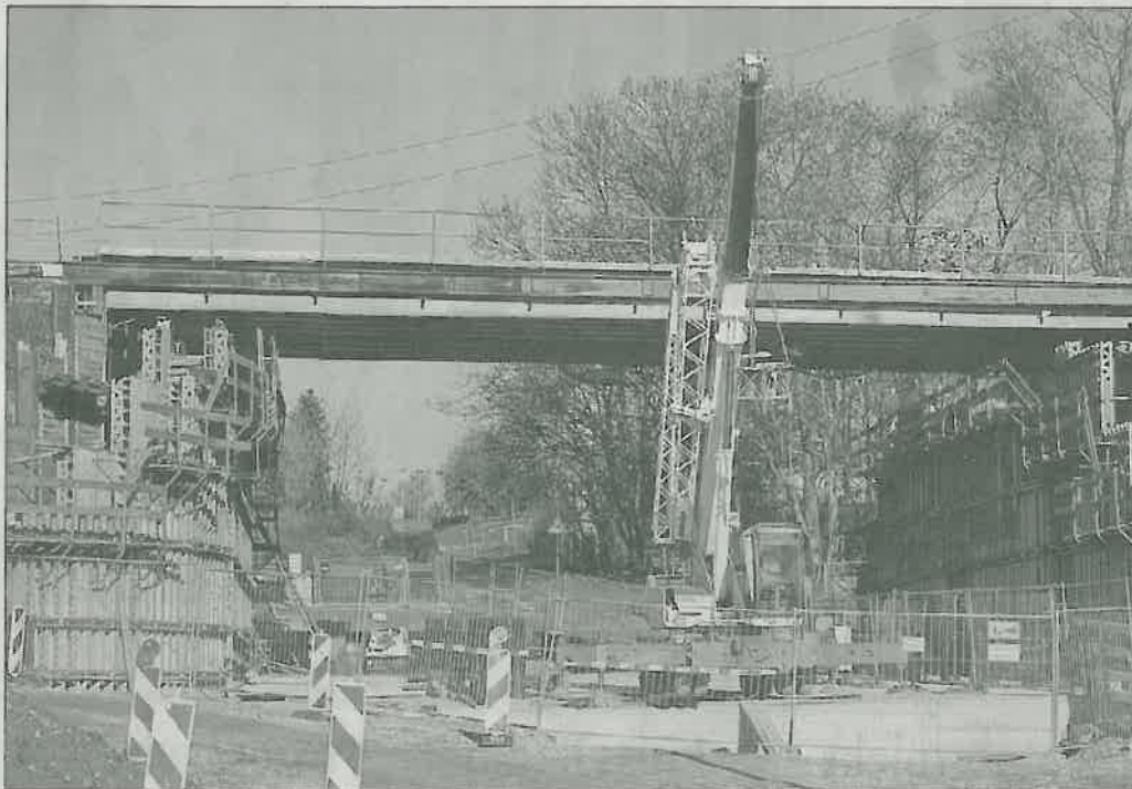
Nach Abschluss des Brückenneubaus für die Bahnlinie Dresden-Görlitz kann der Baustart für die Bautzener Westtangente erfolgen.
